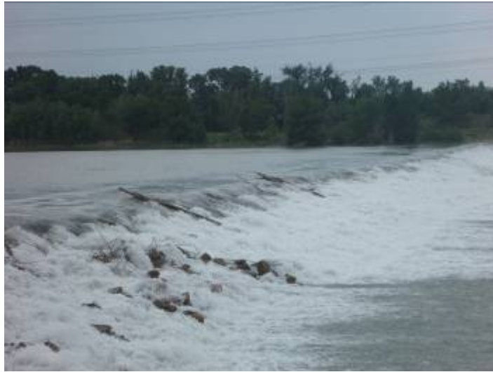
Seuil 68 à Avignon
