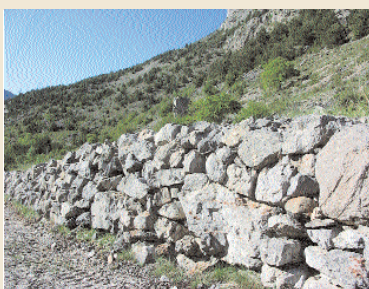
La Roche de Rame : 2x600 m de restauration de muret
