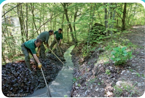
Contrat Natura 2000 d'entretien de canaux d'irrigation - Bréziers.
