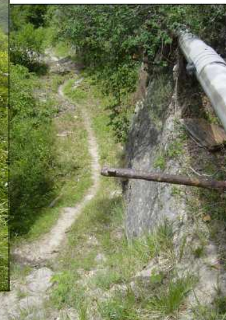
(3) Descente par l'escalier
