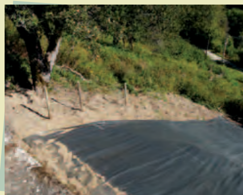
Station de renouée après travaux
