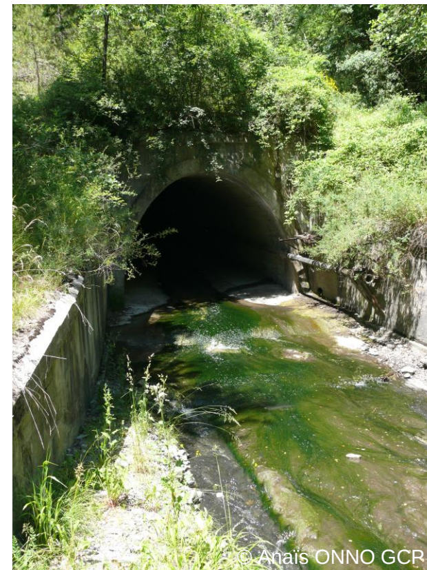
Pont rail du torrent de Marasse au sud
