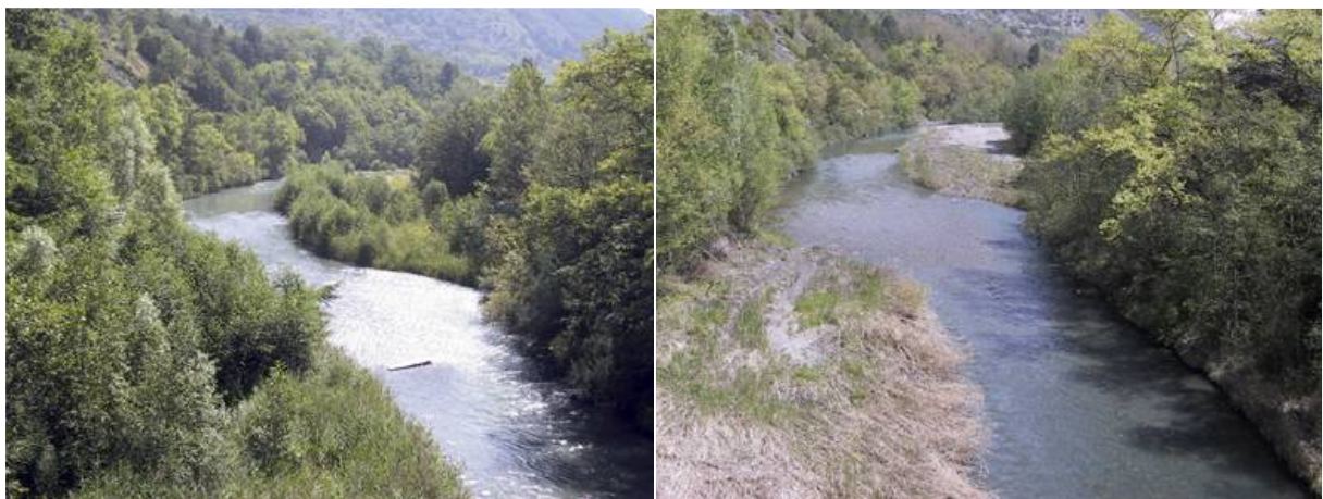
Photo 28 : Vue de la Durance à l'amont de l'Escale, avant et après une opération d'essartement
