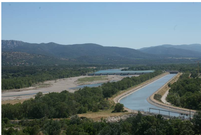
Photo 4 : L'aménagement agro-industriel de la Durance dérive la quasi-totalité de l'eau de la rivière (vue du barrage de Mallemort)
