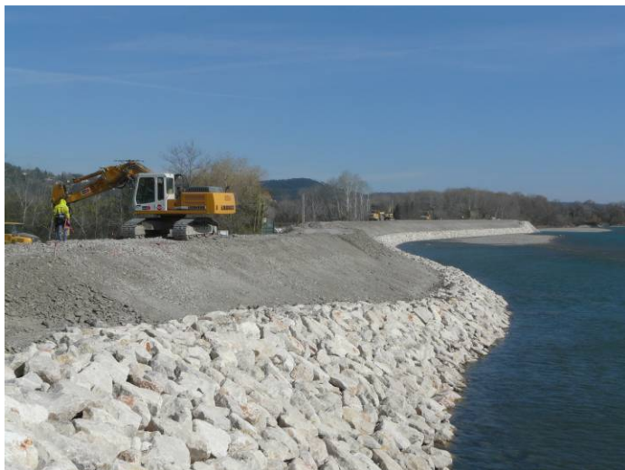
Photo 21 : Digue de Lauris lors des travaux de reconstruction hiver 2008-2009
