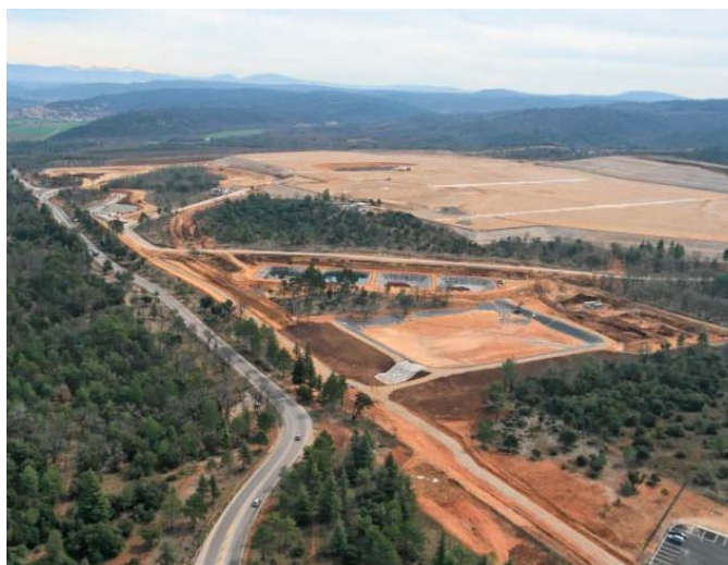
Photo 27 : Une vue du site de la plate-forme du futur réacteur Iker
