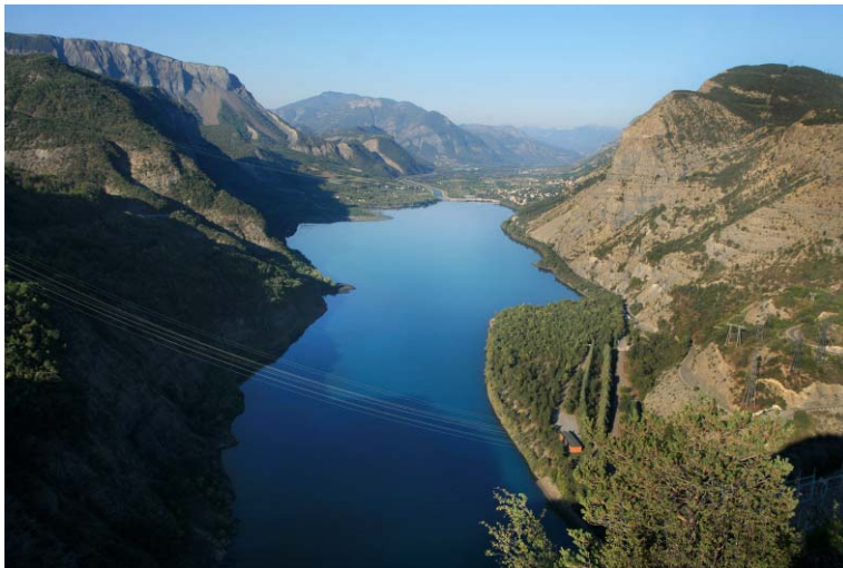
Photo 17 : Le bassin de compensation Espinasse - Rousset vu depuis le barrage de Serre-Ponçon
