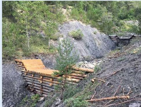
Illustration 16: Construction en mélèze d'un ouvrage de correction torrentielle - Combe des Puys
