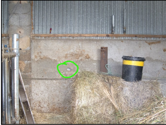
Muret de hangar
