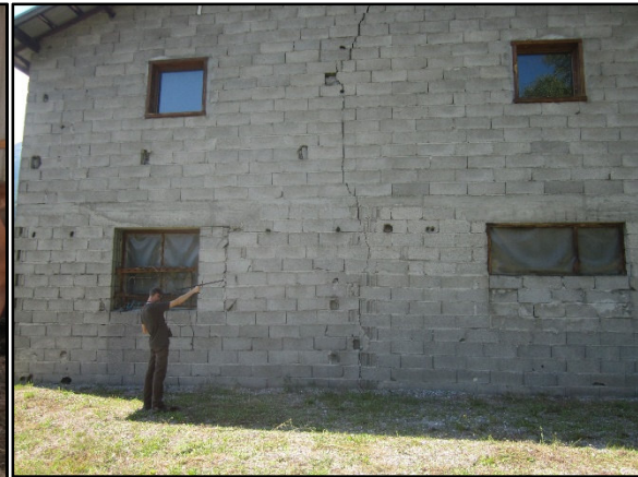
Mur de bâtiment (nombreux gîtes sur les 4 façades)
