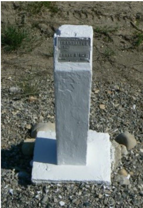
Photo 3 : Borne signalant la présence de la conduite d'éthylène
